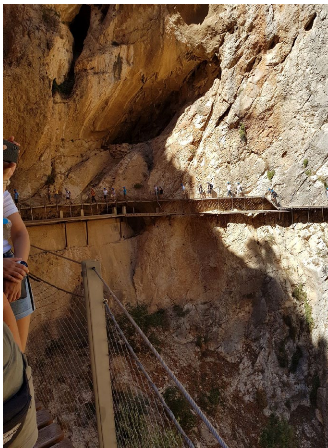
El Caminito del Rey – wąskie drewniane kładki zabezpieczone metalową siatką i poręczami
